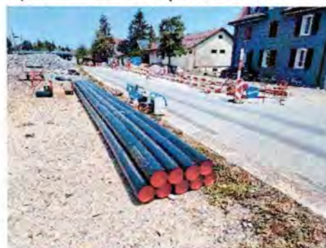
Changement de conduites, rue de l'Orbe
