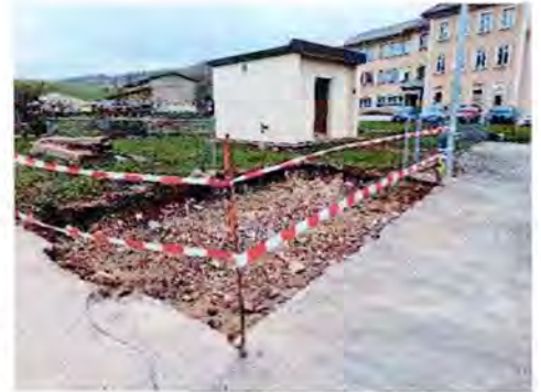
Démontage de l'ancienne cabane de pompage au Lieu
