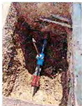
Remplacement d'une vanne de réseau à la Golisse par le personnel de ValRégIEaux
